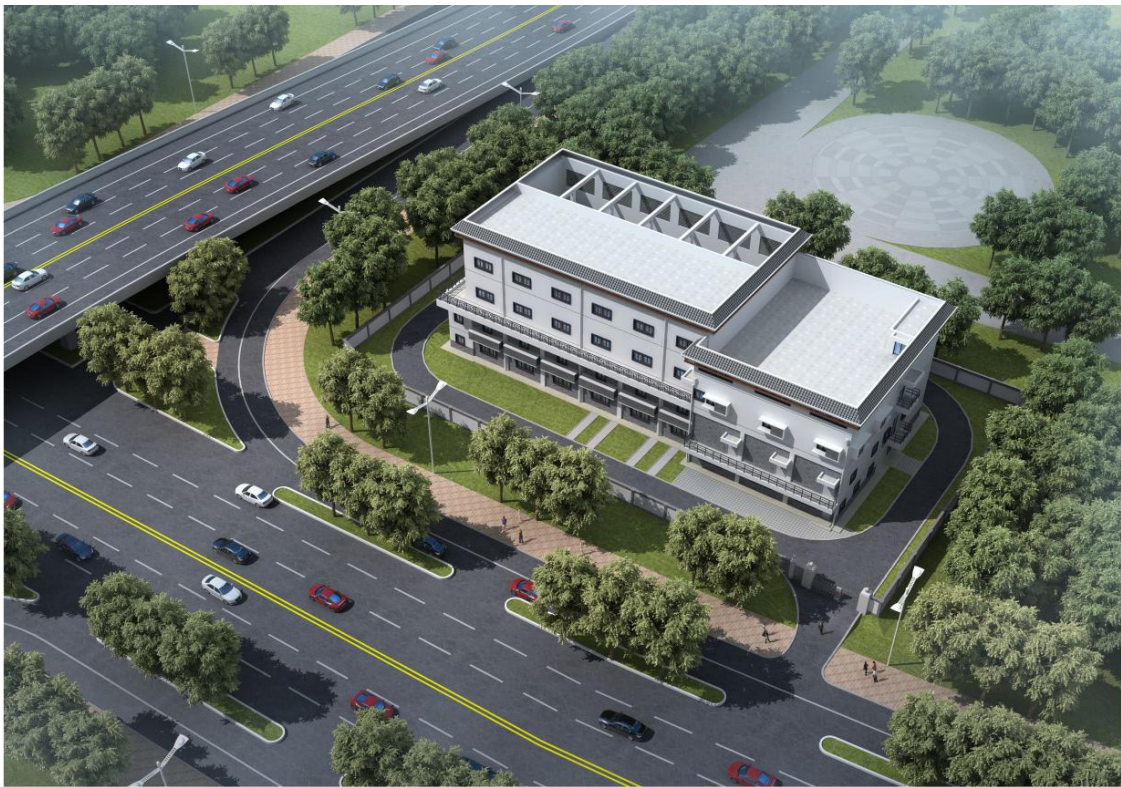
110kV 润亭（亭江）变电站
