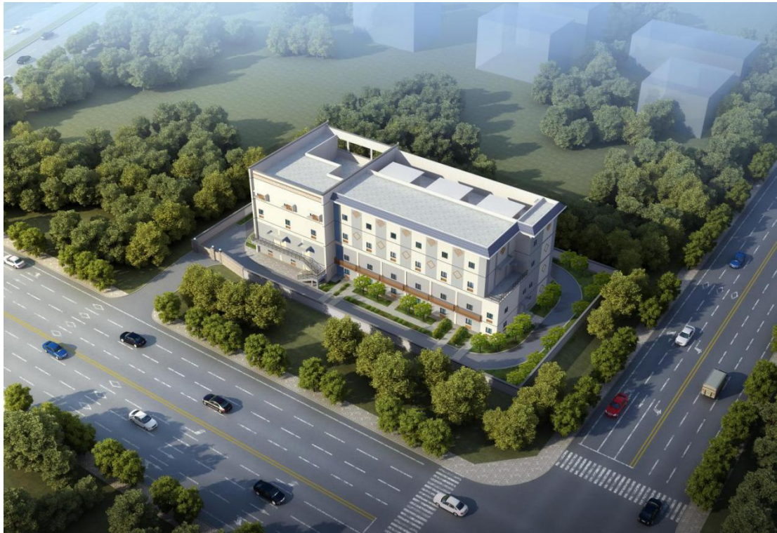
110kV 开泰（江口）变电站
