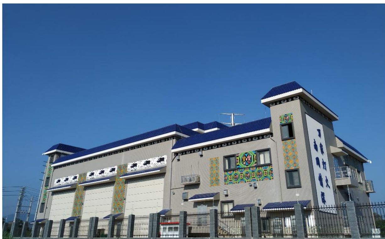
(中国南方电网 2019 年度优质工程奖:110kV 石林变电站工程)
