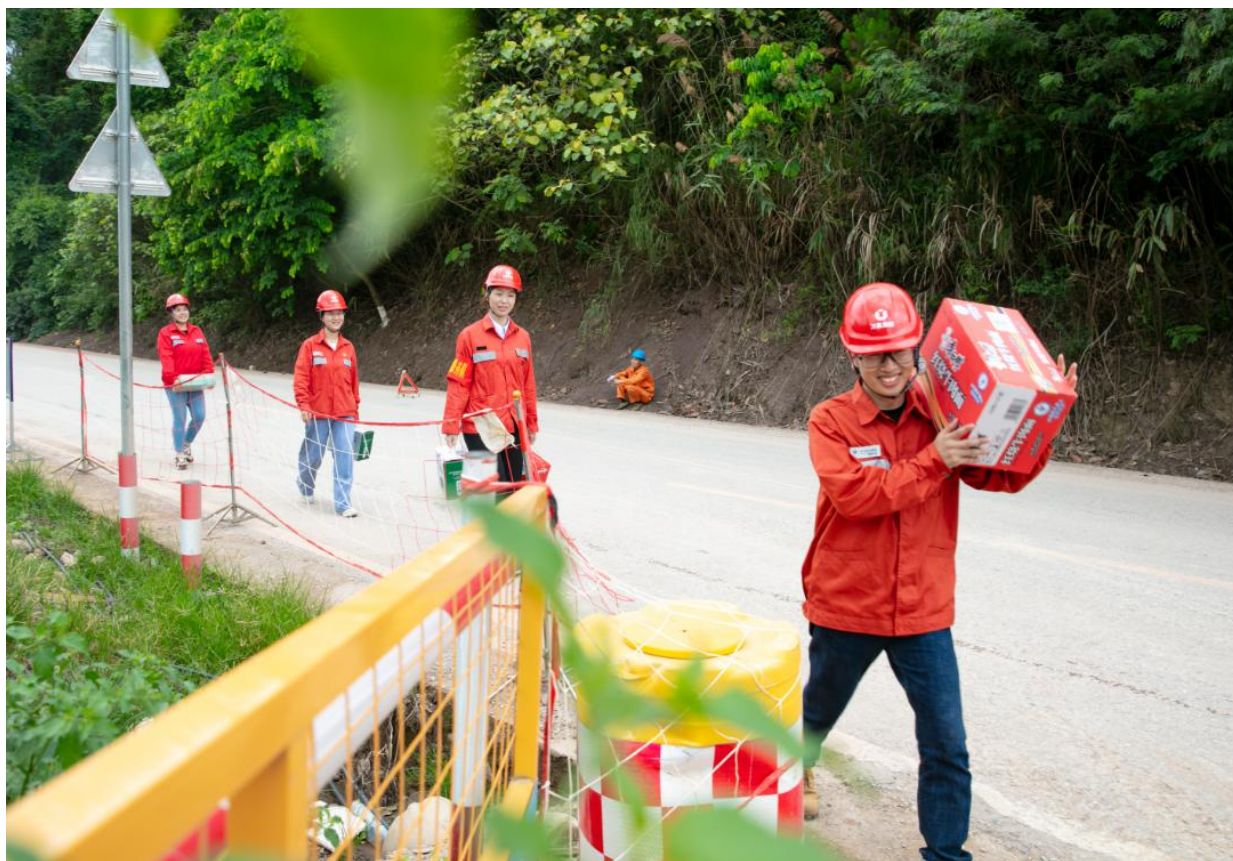
（公司工会到一线工地进行慰问）
